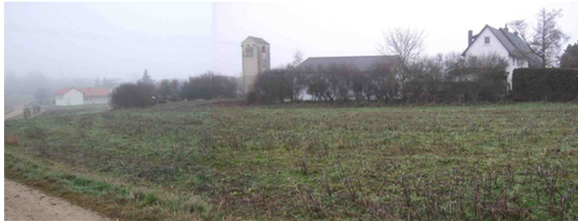
Abbildung 4: Der Ortsrand im Bereich der Trafostation
